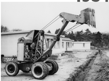
Pelle compacte SK2 Pinguely - Première pelle compacte au monde sur pneumatique sans déport arrière.
